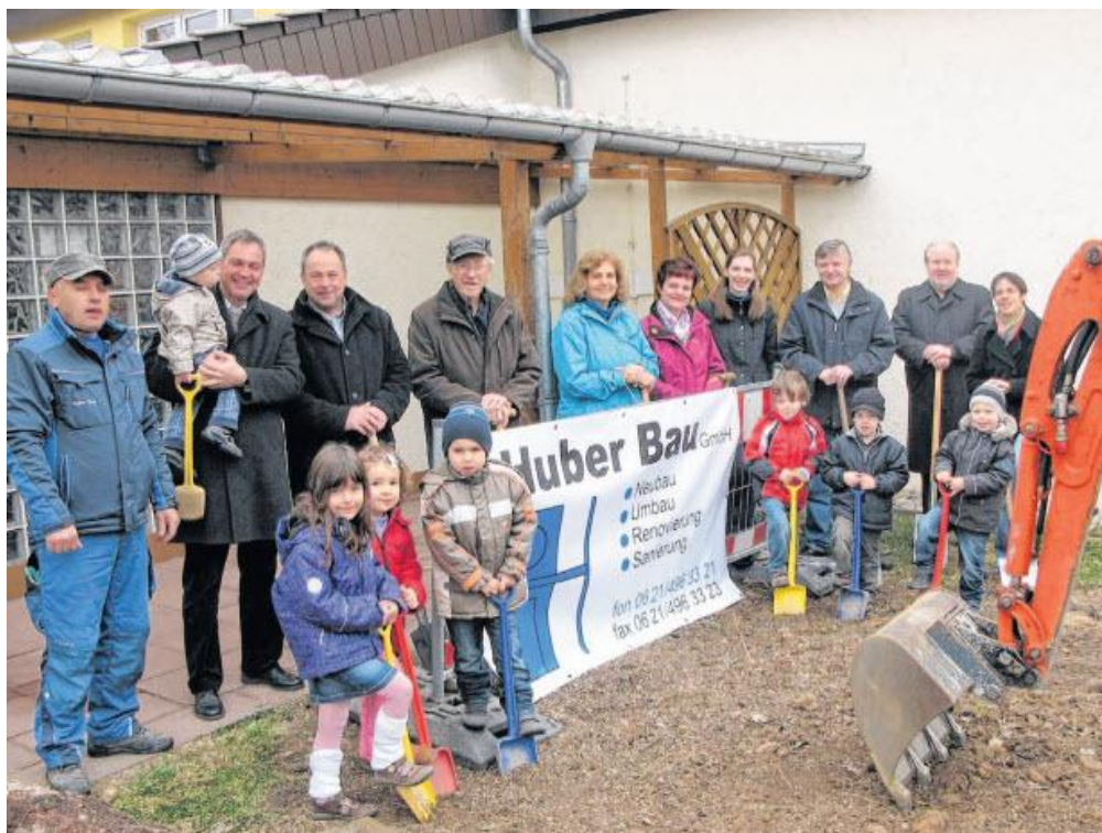
Der Kindergarten St. Josef wird bald größer: Beim ersten Spatenstich mit Bürgermeister Andreas Metz standen alle Beteiligten voller Vorfreude im Bereich des künftigen Speiseraums.
